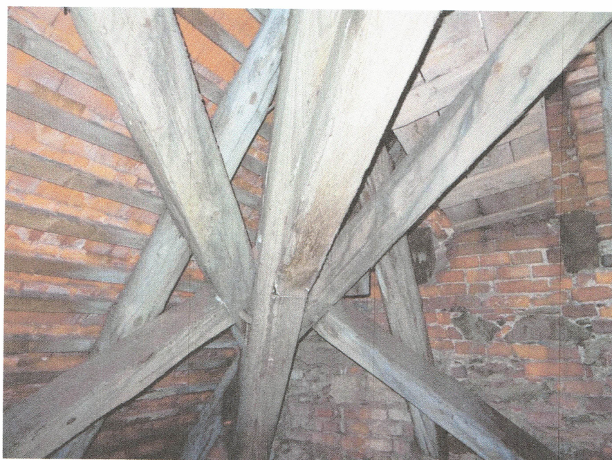
Vzorek č. 4 Bílé inkrustace na spojích trámů – negativní
