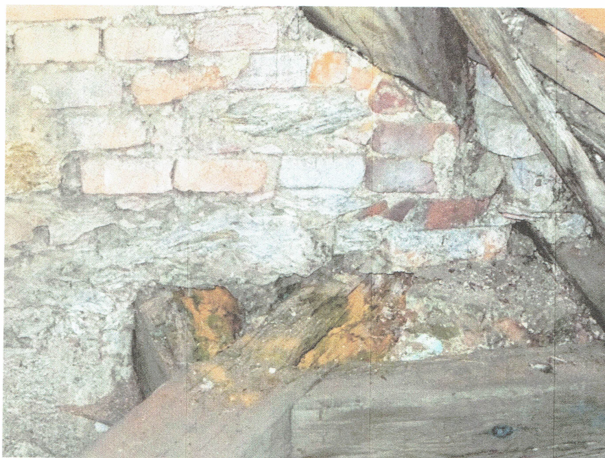
Vzorek č. 3 zhlaví trámů – trámovka plotní
