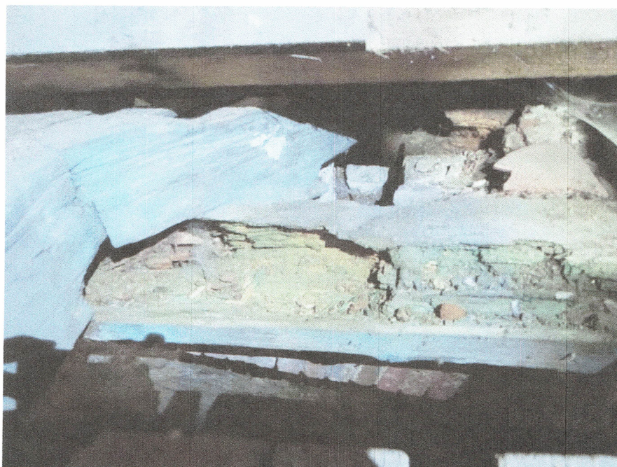
Vzorek č. 1 Pozednice - dřevomorka domácí
